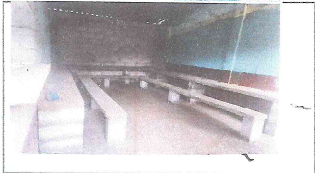
Foto 4: Construcción de Comedor
