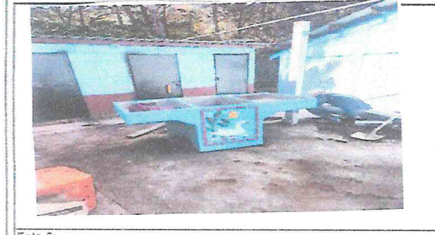
Foto 5: Colocación de Pila
