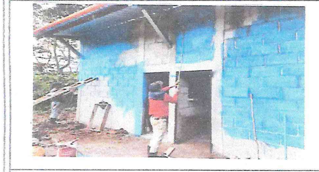
Foto 1: Mantenimiento de paredes
