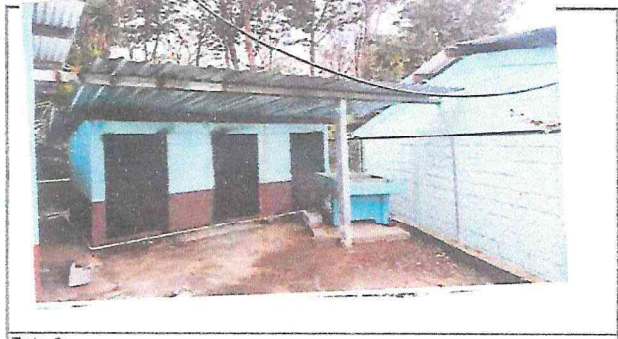
Foto 6: Instalación de Calera Pila
