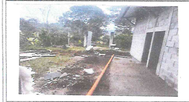
Foto 3: Instalación de Drenaje
